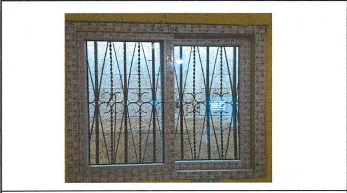
Foto 14: Sustitución de estructuras de metal de ventana
