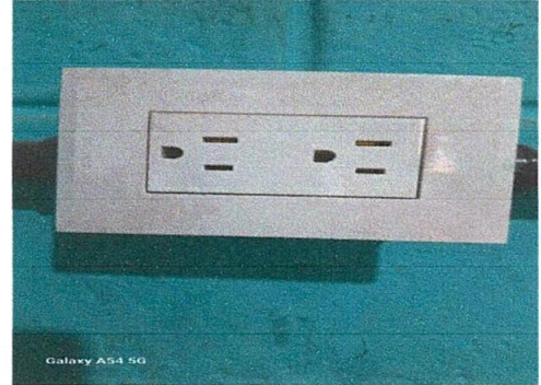
Foto 8: Sustitución de tomacorrientes dobles
