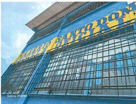
Foto 9: Mantenimiento de balcones de metal
