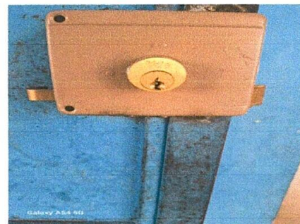
Foto 12: Sustitución de chapa
