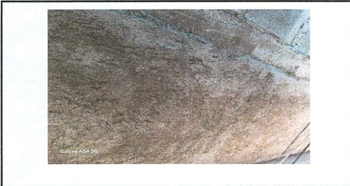
Foto 17: Aplicación de repello de muro de contención
