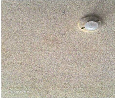
Foto 7: Sustitución de focos ahorradores
