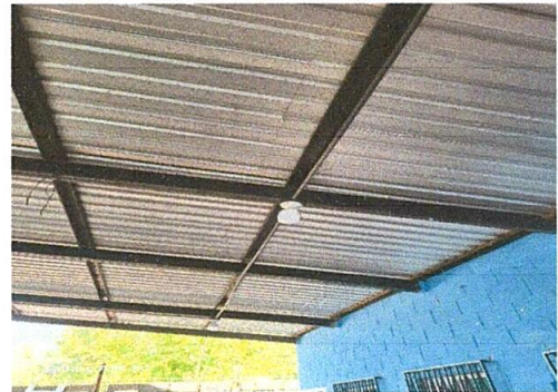
Foto 10: Sustitución de cableado eléctrico
