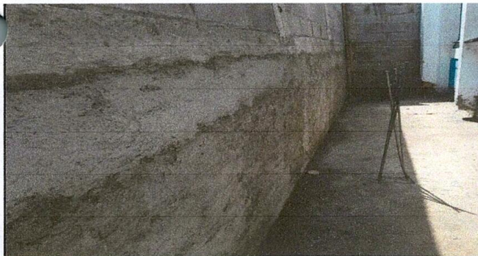
Foto 17: Aplicación de repello de muro de contención
