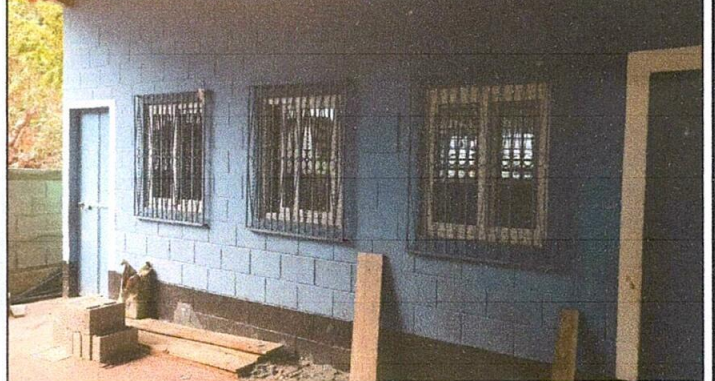
Foto 14: Sustitución de estructuras de metal de ventana
