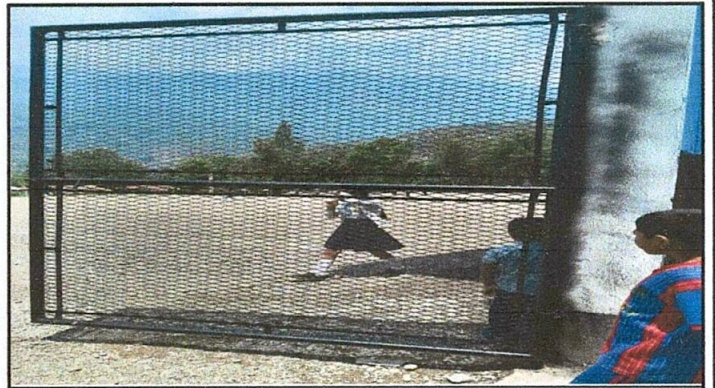
Foto 16: Mantenimiento portones de metal
