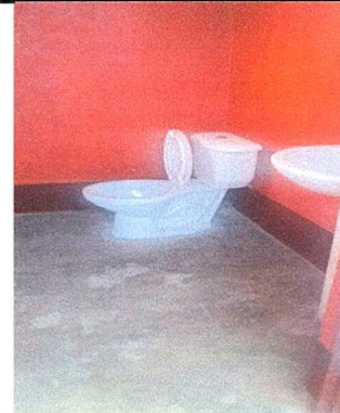
Foto 2: sustitución y mantenimiento de baños. Y lavamanos.
