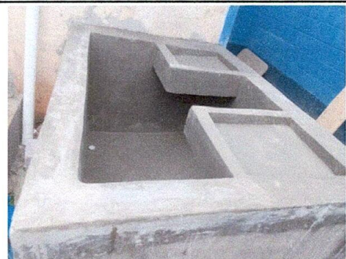
Foto 4: Mantenimiento de pia tipo tanque
