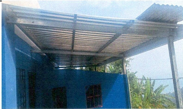
Foto 3: sustitución de estructura portante
