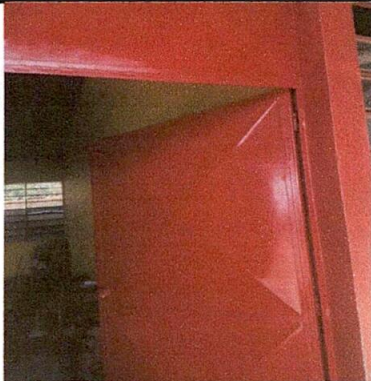
Foto 1: mantenimiento de puertas .
