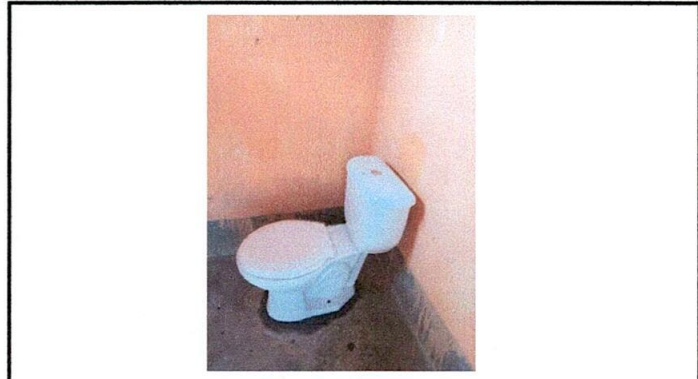
Foto 2: sustitución y mantenimiento de baños. Y lavamanos.
