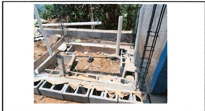
Foto 4: Mantenimiento de pila tipo tanque
