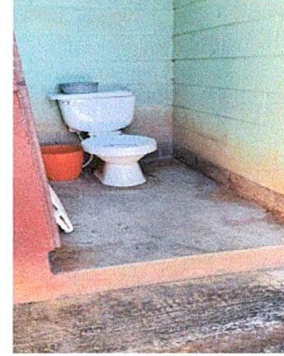
Foto 2: sustitución y mantenimiento de baños. Y lavamanos.
