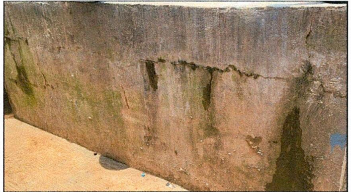
Foto 4: Mantenimiento de pila tipo tanque
