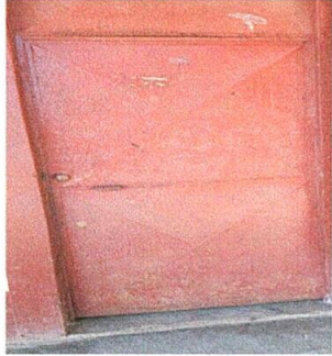
Foto1: mantenimiento de puertas .
