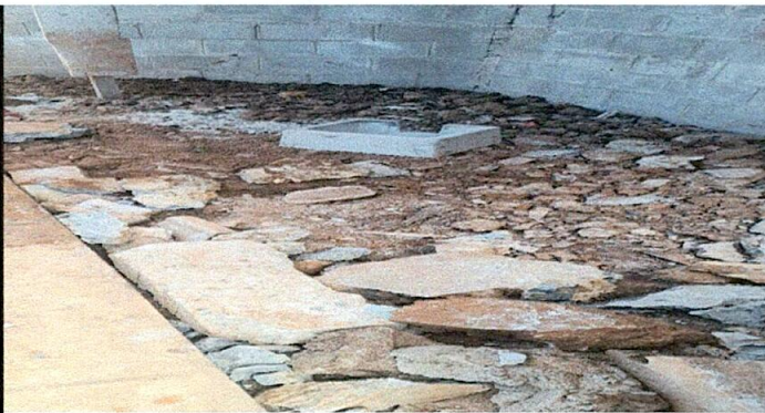
Foto 5: sustitución de piso de concreto a piso antideslizante en módulo de cocina
