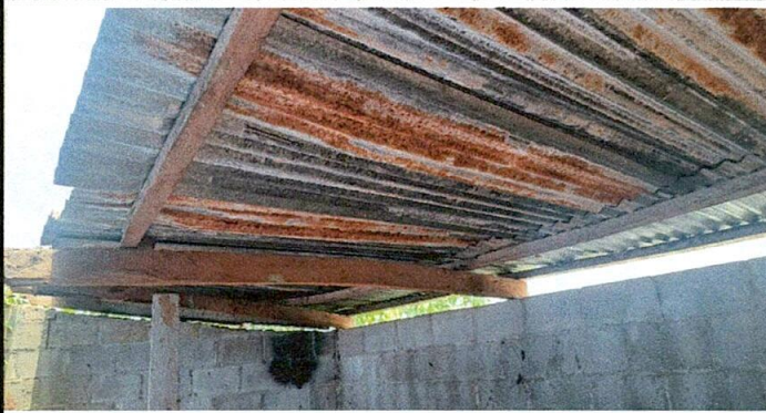
Foto 3: sustitución de estructura portante
