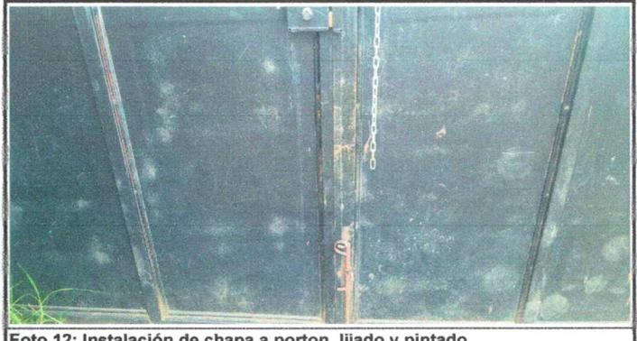
Foto 12: Instalación de chapa a porton, lijado y pintado
