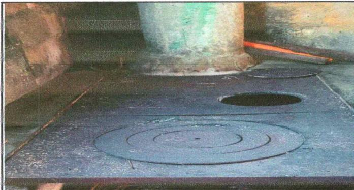
Foto 3: Sustitución de plancha
