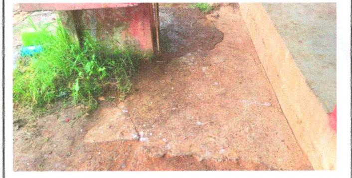
Foto 7: Reparación de losa de concreto de patio
