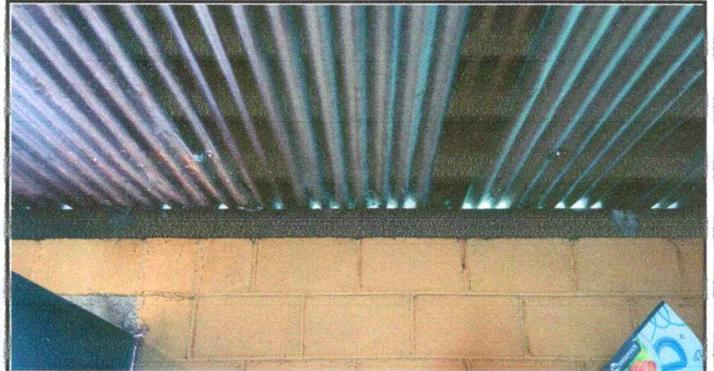
Foto 2: sustitución de estructura madera por metal
