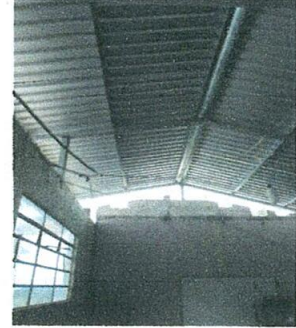
Foto 2: Cambio de lámina de aulas terminado.
