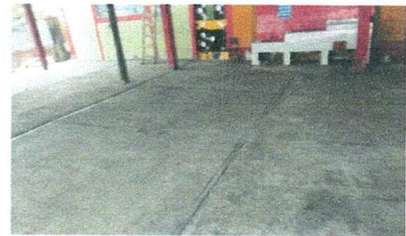
Foto 6: Remodelación piso de patio terminado.
