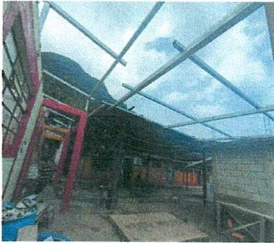
Foto 3: En proceso de cambio de lámina del lado izquierdo del salón.
