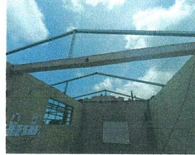
Foto 2: En proceso de cambio de estructura de madera por metal.
