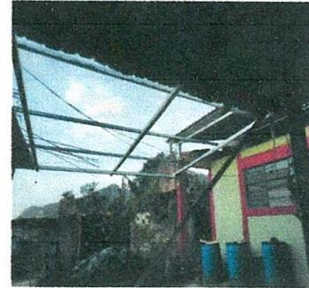
Foto 4: En proceso de cambio de estructura de madera por metal, del lado izquierdo del salón.
