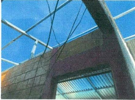
Foto 1: En proceso de cambio de lámina de aulas
