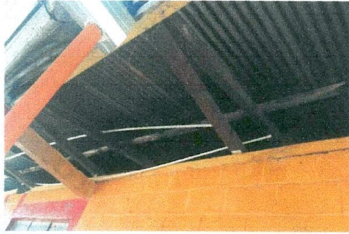
Foto 1: Sustrucción de lamina de 2 aulas .
