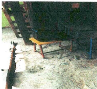
Foto 5: Mejoramiento de torta de concreto del salón
