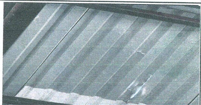
Foto 2: Estas láminas de calibre delgado estan partidas y cae mucha agua en los salones de claseses y nos ha dificultado en el invierno
