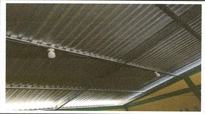
Foto 2: Sustitución de estructura de metal terminado.
