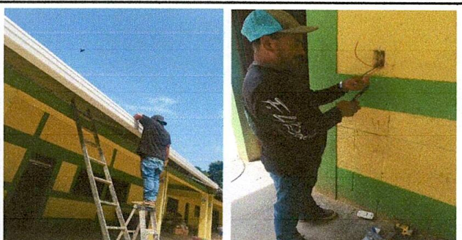
Foto 6: En proceso de reparación de bajadas de agua pluvial y sustitución de tomacorrientes eléctricos.
