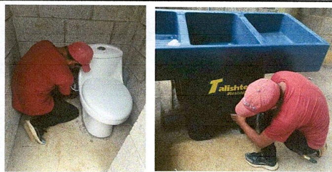
Foto 5: En proceso sustitución de inodoros y pila plástica de dos lavaderos.
