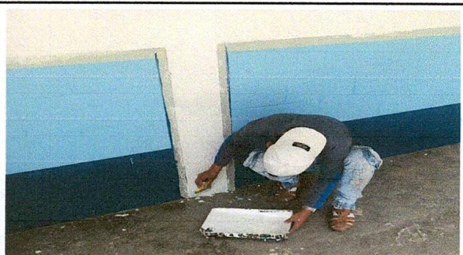
Foto 4: En proceso de aplicación de pintura en muros exteriores e interiores.
