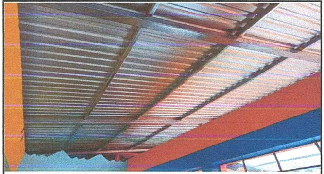
Foto 2: Techado finalizado visto desde adentro de las aulas.
