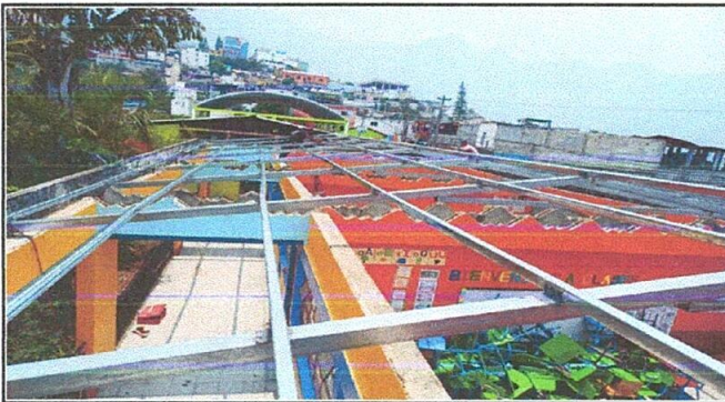
Foto 3: Sustitución de estructura metálica.
