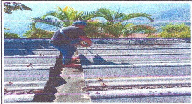
Foto 2: Por la antigüedad la teja se está quebrando y entra mucha gotera a las aulas
