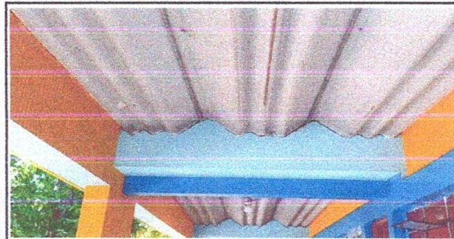
Foto 5: Por la antigüedad las tejas se están desgastando y en invierno pasa mucha agua
