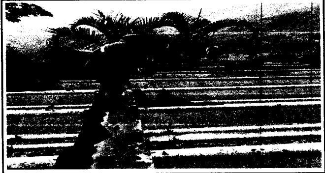
Foto 2: Por la antigüedad la teja se está quebrando y entra mucha gotera a las aulas
