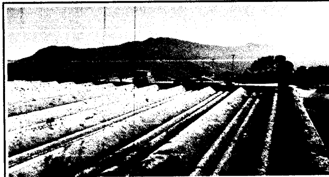
Foto 3: Por el invierno los canales se tapan, provoca mucha humedad
