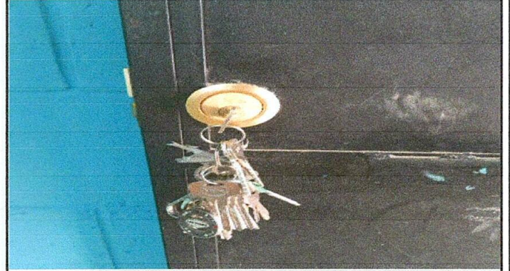
Foto 2: Sustitución de chapas
