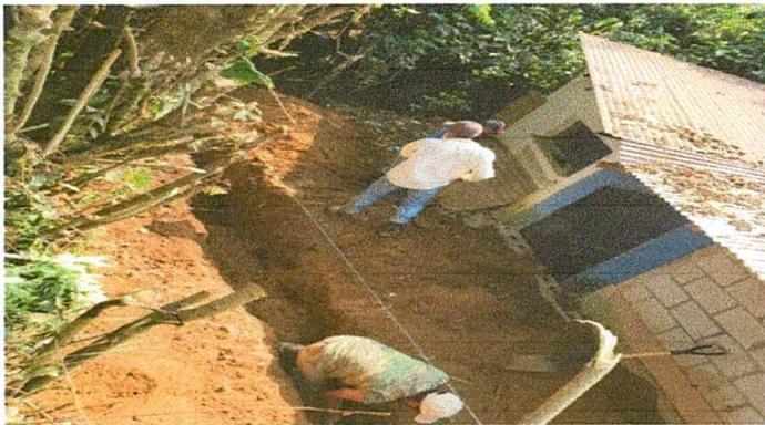
Foto 3: Cimiento de muro para circulación
