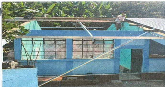
Foto 5: Soldadura de costaneras para preparación de techo en el aula de párvulos
