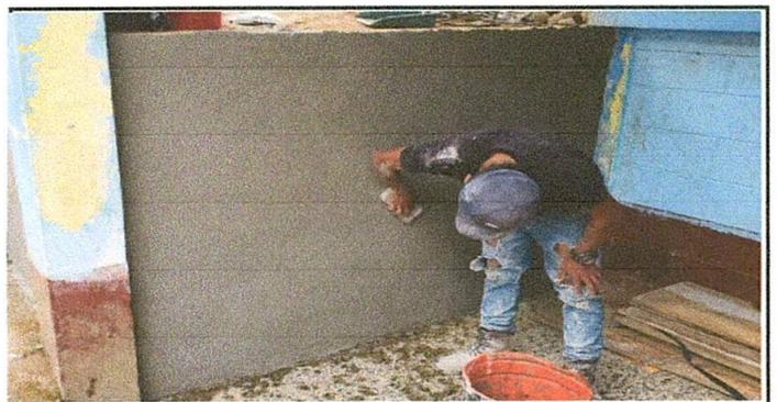
Foto 6: Repello de un muro frente a la cocina
