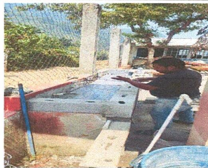
Foto 6: reparación y ampliación de lavamanos colocado de azulejo y cambio de chorros con tubería nueva
