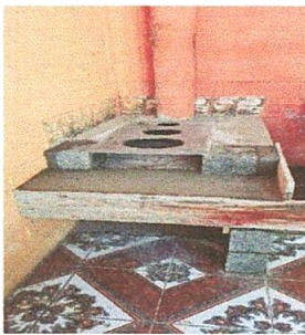
Foto 5: reparación de estufa, cambiando planchas y tubo de salida de humo y ladrillos
