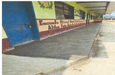
Foto 4: reparación de planchas de concreto en el área de patio
