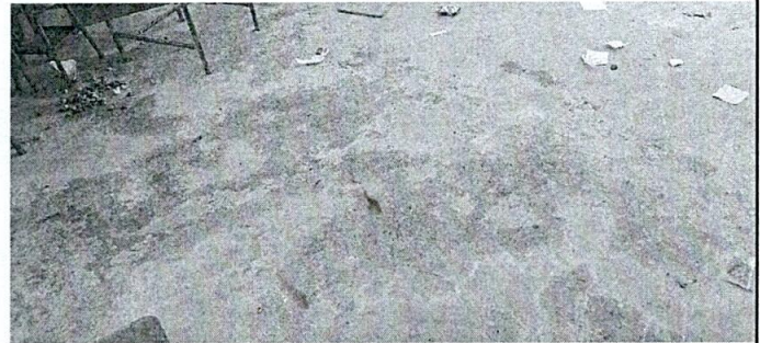
Foto 2: sustitución de piso en aulas.
