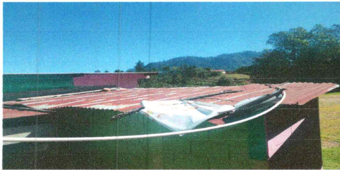
Foto1: sustitución de lámina
