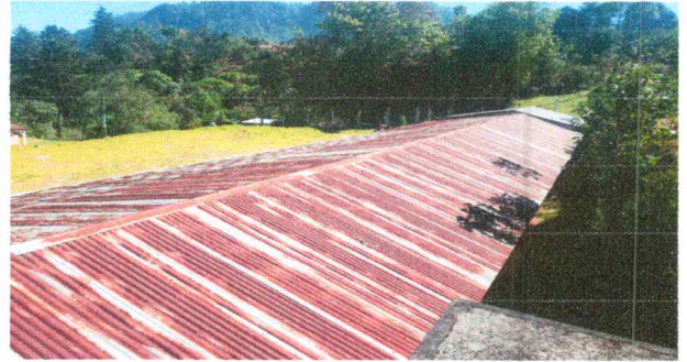
Foto 2: sustitución de lámina
