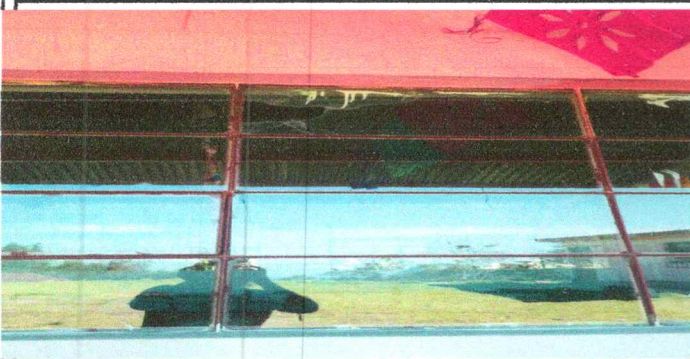
Foto 3: sustitución de vidrios
