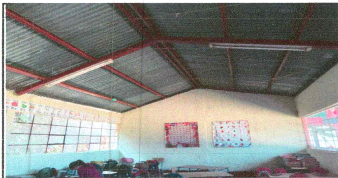
Foto 5: sustitución de bombillas y plafoneras
