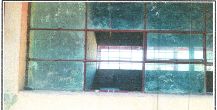
Foto 4: Sustitución de Vidrios
