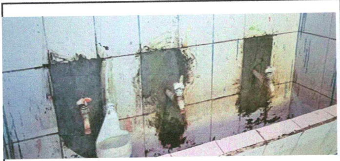
Foto7: Sustitución de accesorios en migitorio y lava manos
