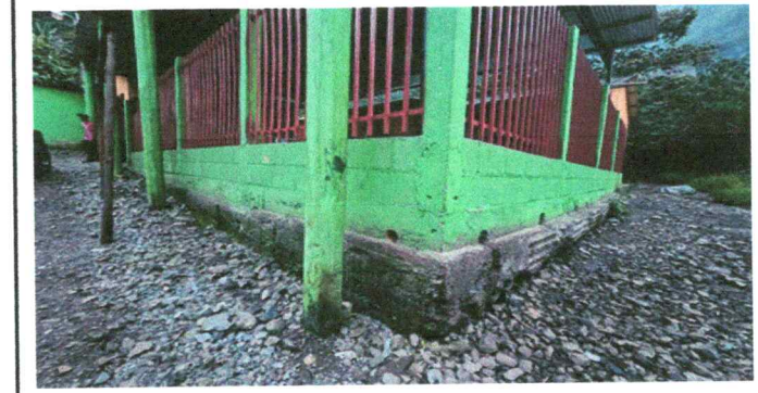
Foto 9: Mejoramiento de muro perimetral repello
