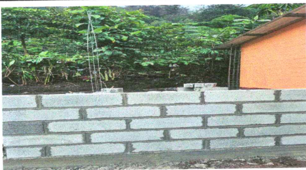
Foto 5: Mejoramiento de paredes de la cocina
