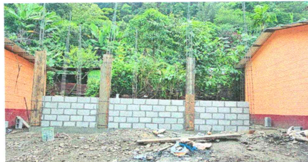
Foto 2: Mejoramiento de estructura de soporte de metal en cocina
