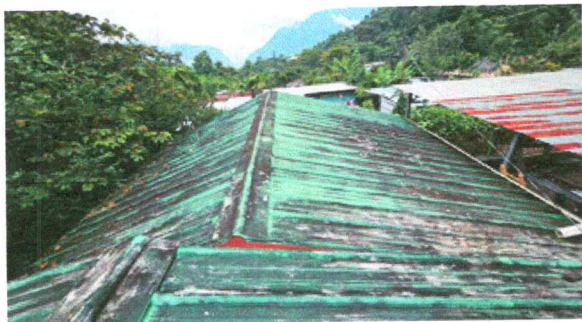
Foto1: Sustitución de lámina en mal estado.
