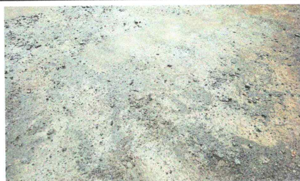
Foto 4: Mejoramiento del piso de granito de la cocina (Cemento)
