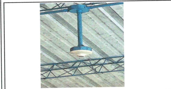
Foto 10: Mejoramiento de lamparas led
