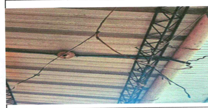
Foto 10.1: Sustitución de plafoneras por plafoneras
