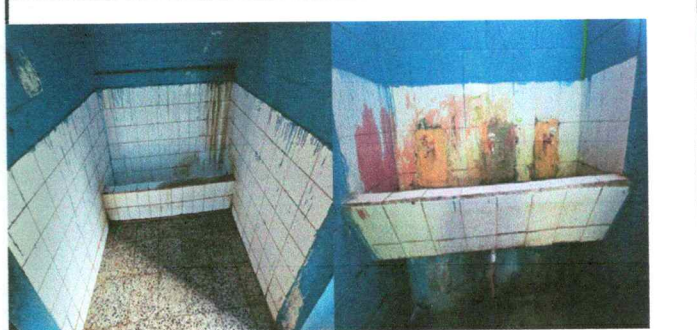
Foto 7.1: Sustitución de azulejo por azulejo
