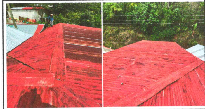
Foto 4: Sustitución de lámina por lámina Técnico aluzinc calibre 26
