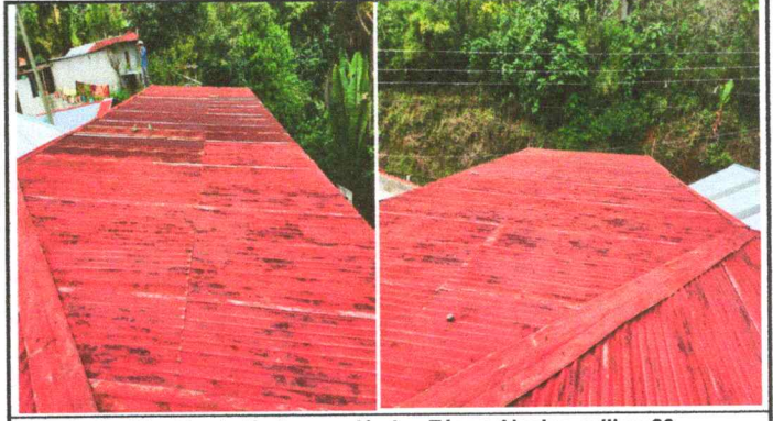
Foto 2: Sustitución de lámina por lámina Técnico Aluzinc calibre 26
