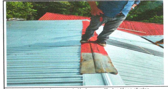
Foto 6: Sustitución de capote de lámina para lámina técnico aluzinc
