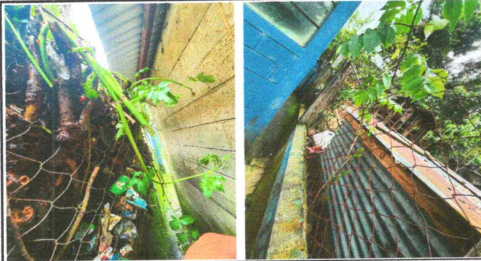
Foto1: Reparación 18 m2 de muro perimetral de block
