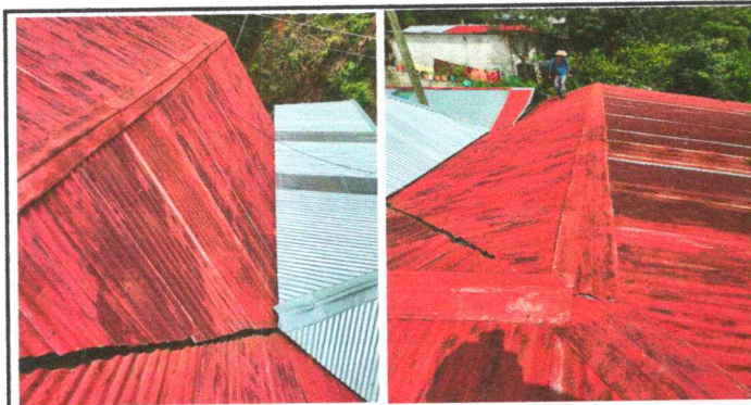
Foto 3: Sustitución de capote de lamina por capote de lámina Técnico Aluzinc
