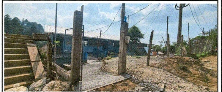
Foto 4: pavimento de entrada de escuela
