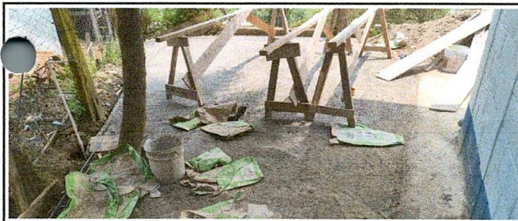
Foto 5: Reapación de patio terminado
