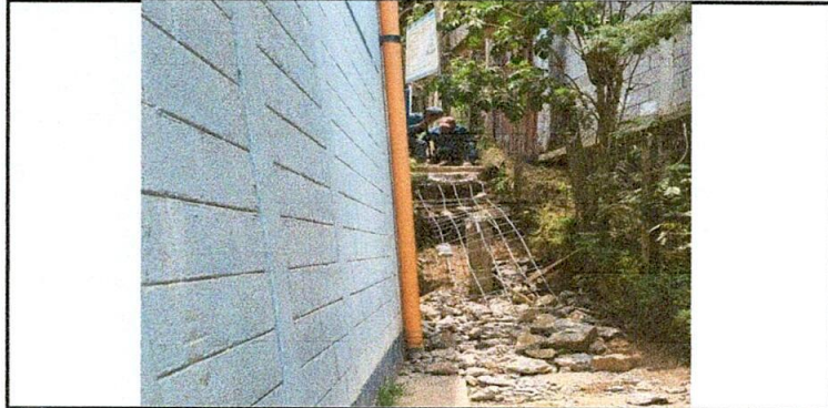
Foto 1: Demolición de gradas
