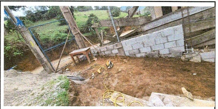
Foto 2: construcción de muro perimetral
