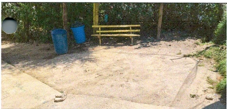
Foto 5: Reparación de patio
