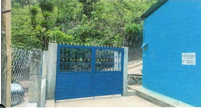
Foto 1: Fabricacion e instalacion de porton de estructura metalica de 2.35 m\*2.10 m.
