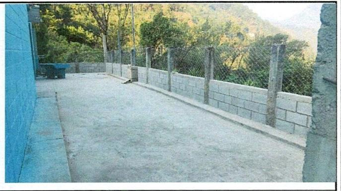
Foto 4: Se construyo muro perimetral de block y solera de intermedia, mas malla galvanizada de 1 metro
