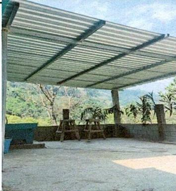
Foto 3: Se intalo techo de lamina aluzinc calibre 26, y se reubico la nueva pila de cemento con 2 lavadores
