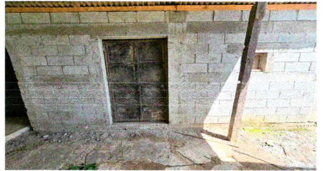
Foto 6: Reparación de repello y cernido de paredes
