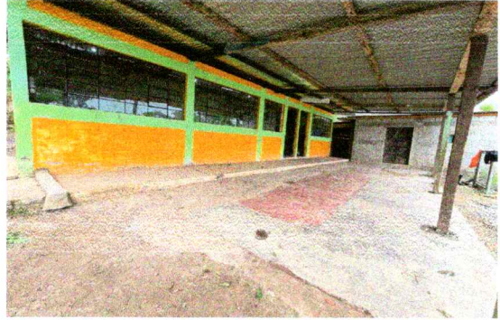
Foto 2: Sustitución de madera por costanera metálica
