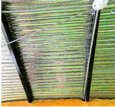
Foto1: Sustitución de lámina de 2 aulas
