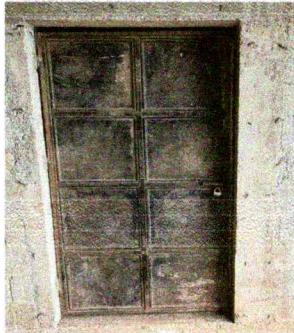
Foto 3: Sustitución de puerta metálica
