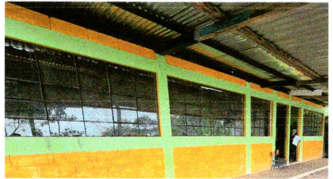
Foto 4: Sustitución balcones de metal
