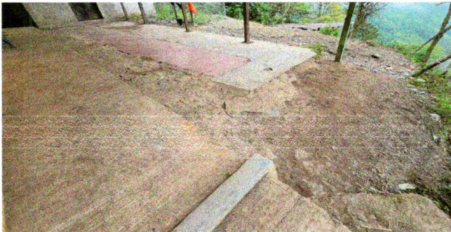
Foto 5: Reparación de plancha de concreto de patio
