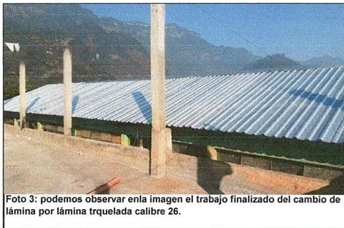
Foto 3: podemos observar en la imagen el trabajo finalizado del cambio de lámina por lámina troquelada calibre 26.
