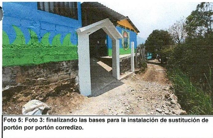
Foto 5: Foto 3: finalizando las bases para la instalación de sustitución de portón por portón corredizo.
