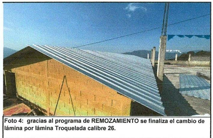
Foto 4: gracias al programa de REMOZAMIENTO se finaliza el cambio de lámina por lámina Troquelada calibre 26.
