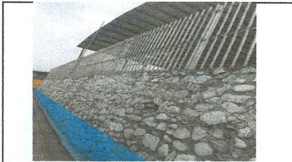
Foto 2: BARNADA YA INSTALADA
