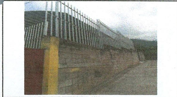
Foto 3: BARANDA INSTALADA EN MURO PERIMETRAL
