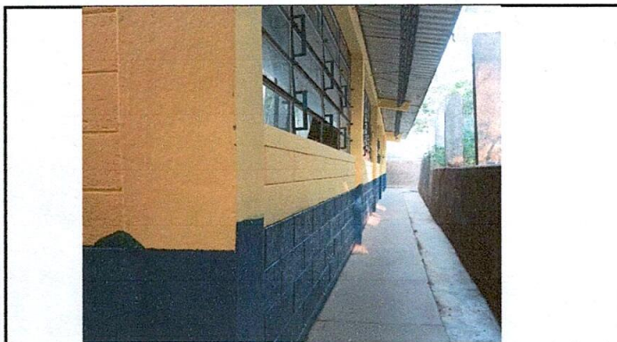
Foto 3: Pintura en muros exteriores e interiores
