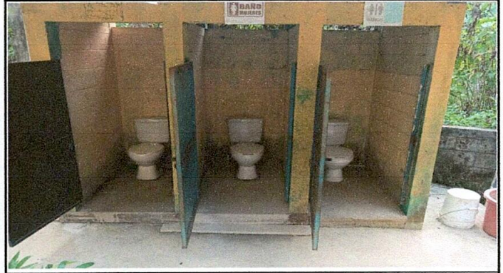
Foto 2: Sustitución de inodoros
