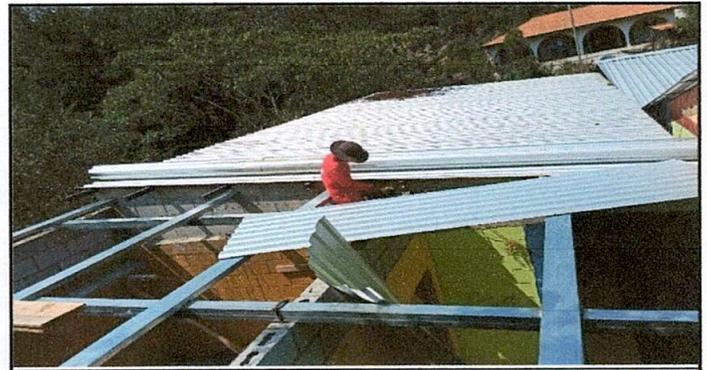
Foto 6: Sustitución de deposito de agua y entechado.
