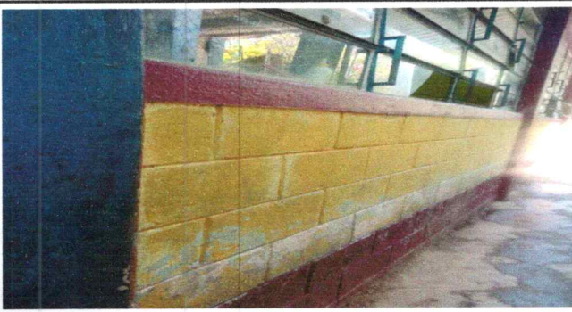
Foto 3: Pintura en muros exteriores e interiores
