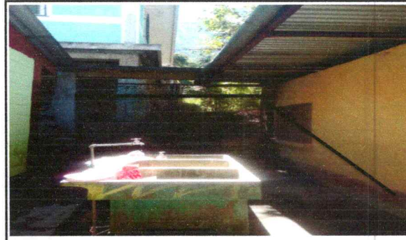
Foto 6: Sustrucción de depósito de agua y entechado.
