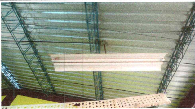
Foto 1: Sustrucción de sistema eléctrico.
