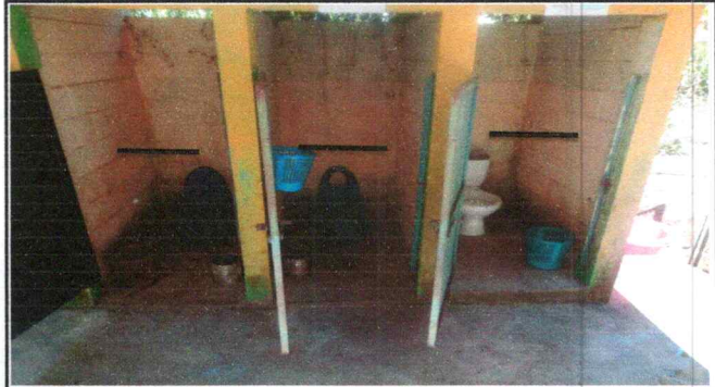
Foto 2: Sustrucción de inodoros
