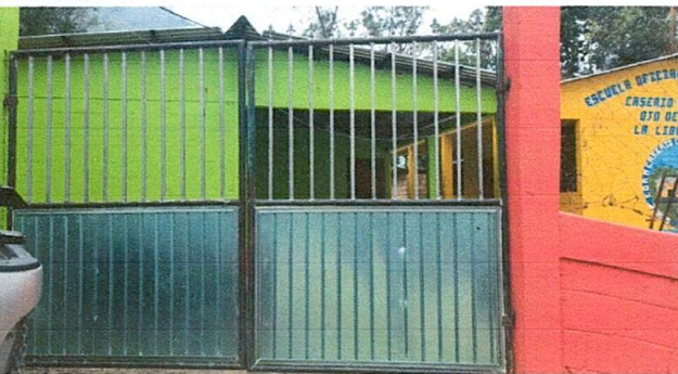
FOTO 5: REPARACION DE PORTON
