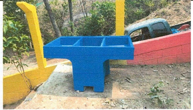
FOTO 2: SUSTITUCION DE TANQUE POR PILA
