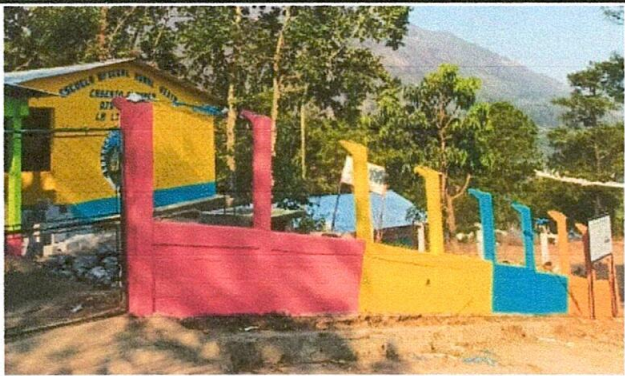
FOTO 3: SUSTITUCION DE PINTURA PERIMETRAL
