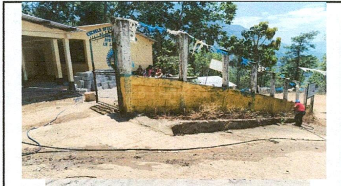
FOTO 3: SUSTITUCION DE PINTURA PERIMETRAL
