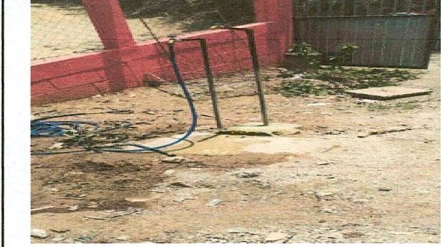
FOTO 2: SUSTITUCION DE TANQUE POR PILA
