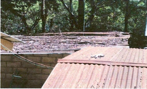
FOTO 1: SUSTIUCION DE LAMINA POR LAMINA CALIBRE 28
