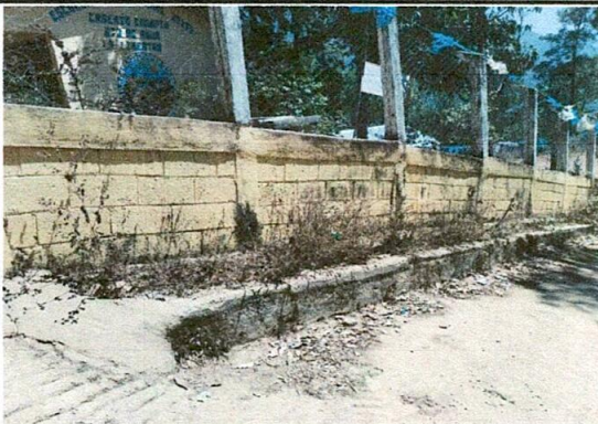
FOTO 3: SUSTITUCION DE PINTURA PERIMETRAL
