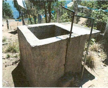
FOTO 2: SUSTITUCION DE TANQUE POR PILA
