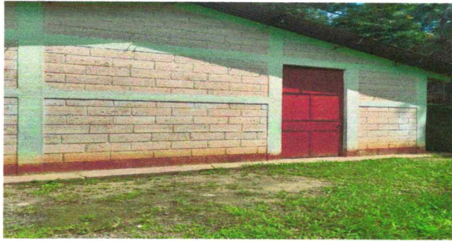
Foto7: Pintura en muros exteriores e interiores
