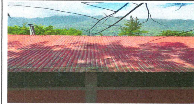
Foto1: Mantenimiento a cubierta de Lámina con pintura
