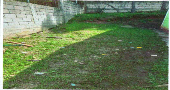
Foto8: Reparación de tubería para drenaje.
