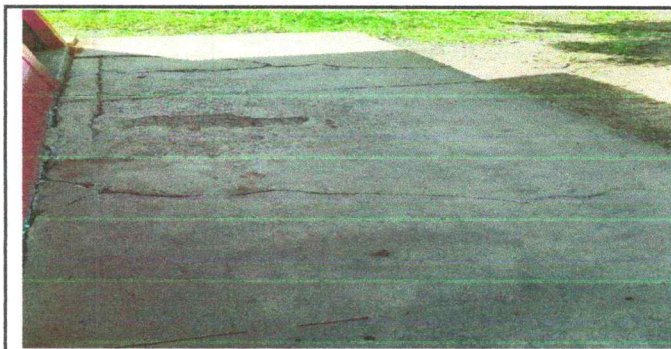
Foto 5: Sustitución de torta de concreto por piso granito
