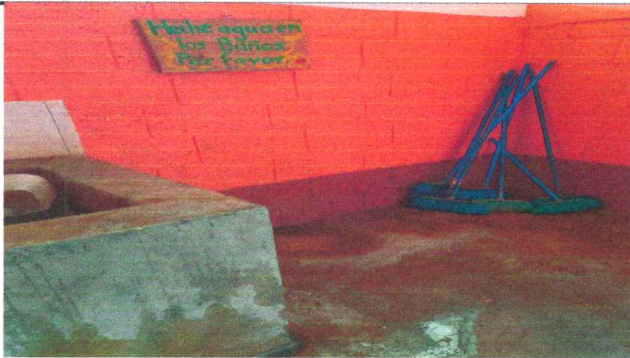
Foto9: Mejoramiento de lavamanos de concreto
