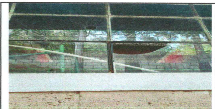
Foto 6: Mejoramiento de ventanas y balcones
