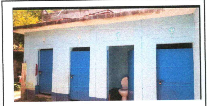
Foto 7: PINTURA EN MUROS EXTERIORES E INTERIORES
