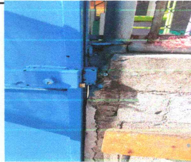
Foto 16: PUERTAS DE METAL, SUSTITUCION DE CHAPAS
