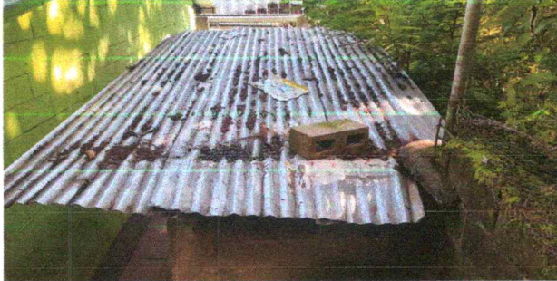
Foto 13: ESTRUCTURA DE TECHO
