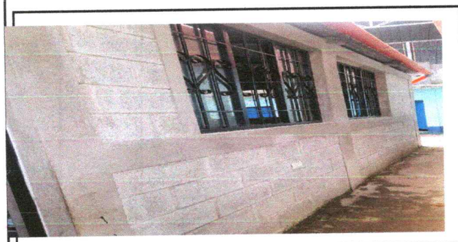
Foto 11: PINTURA EN MUROS EXTERIORES E INTERIORES
