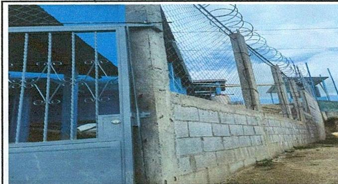
Foto 3: MURO PERIMENTAL DE BLOCK CON TUBO Y MALLA.
