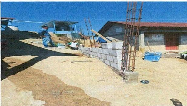
Foto 3: MURO PERIMENTAL DE BLOCK CON TUBO Y MALLA.
