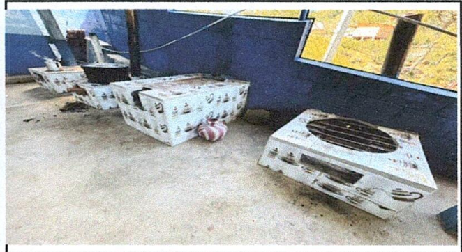
Foto 2: Instalación de azulejo en estufa rural porque se encuentran en mal estado
