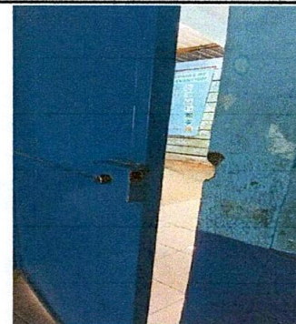
Foto 4: Sustitución de chapa para puerta de metal, porque ya está inservible
