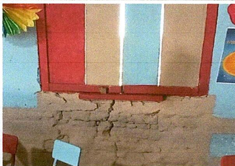
Foto 5: Sustitución de ventanas de madera por ventanas de metal mas vidrios, porque se encuentran en mal estado
