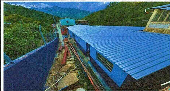
Foto 2. Cambio de techo con estructura de metal
