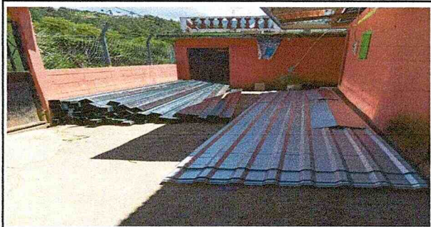
Foto 3: sustitución de estructura de soporte
