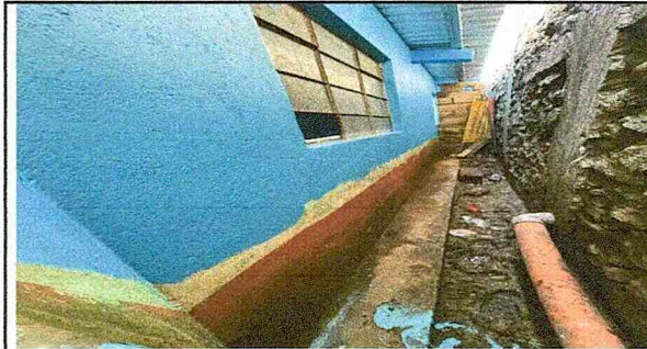
Foto 4: sustitución de estructura de soporte
