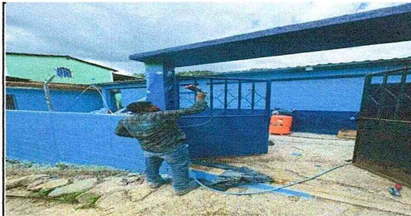
Foto 6. Sustitución de pintura de puerta de metal
