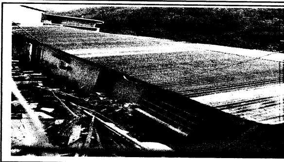
Foto 2. Lámina en malas condiciones
