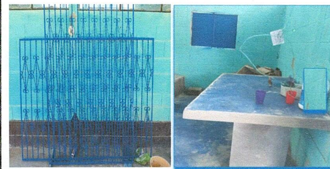
SUSTITUCION DE MUEBLE DE CONCRETO EN LA COCINA
