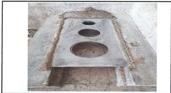
Foto 4: Sustitución de planchas de hornillas
