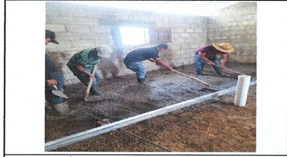
Foto 2: Sustitución de piso de torta
