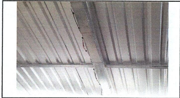
Foto 3: sustitución de estructura de soporte
