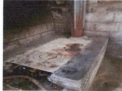
Foto 4: Sustitución de planchas de hornillas
