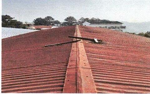
Foto 1: lámina en malas condiciones
