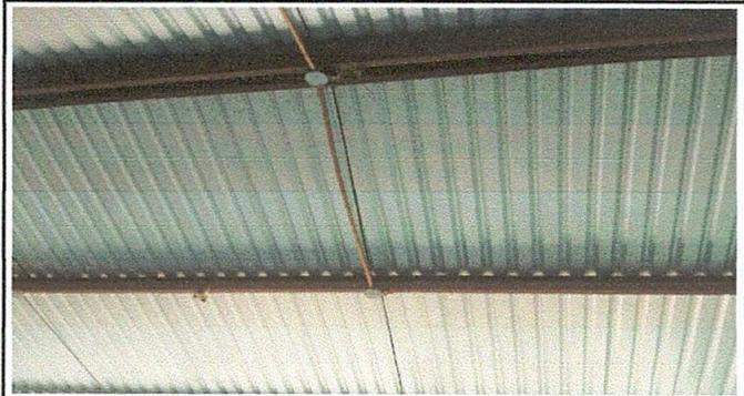
Foto 3: sustitución de lamina
