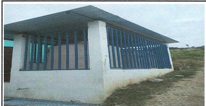
Foto 4: sustitución de malla multichorros
