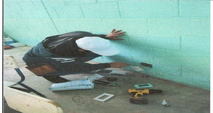
Foto 2: sustitucion de tomacorriente doble
