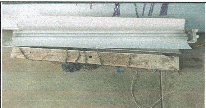
Foto 5: sustitución de base de bombillas
